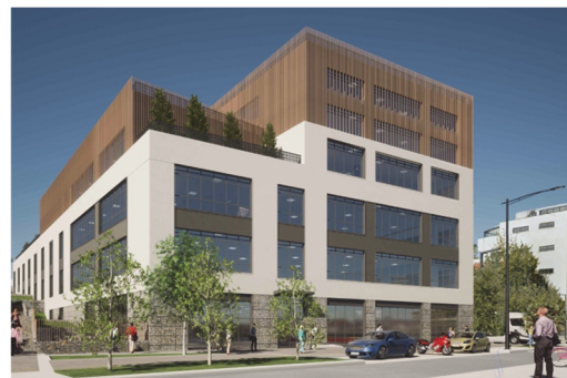
© ALSEI ENTREPRISE—hôtel industriel
